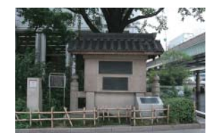
石造二連アーチ橋である日本橋は国の重要文化財に指定されている
